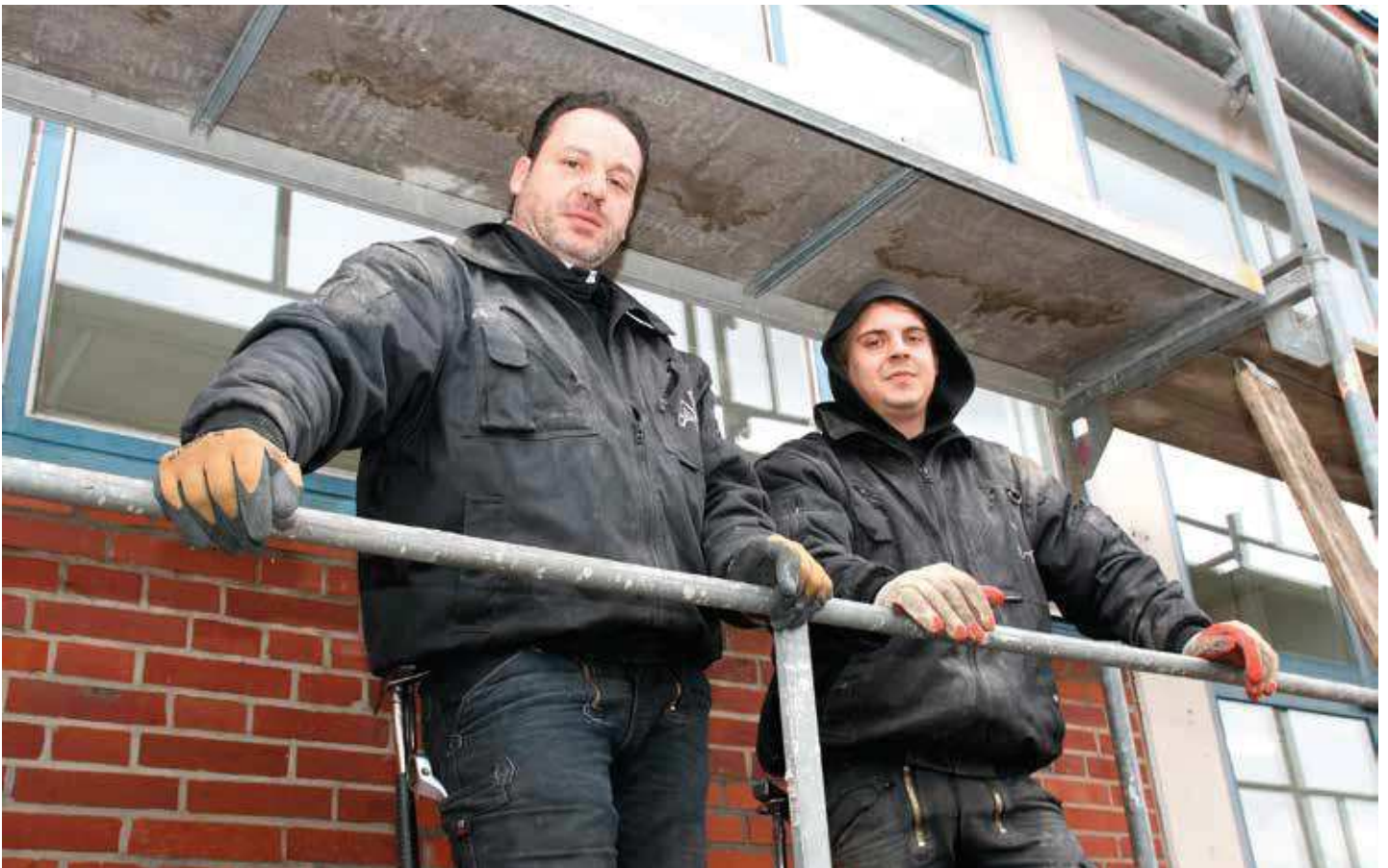
Die Gerüstbauer Markus Yavuz (links) und Fabian Schenk gehen kein Risiko ein, wenn die Witterungsbedingungen ein Arbeiten auf dem Gerüst zu gefährlich machen.
